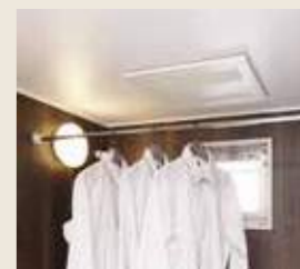
浴室暖房乾燥機
